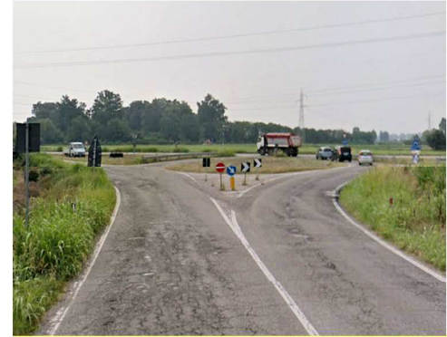
Innesto pericoloso dalla circonvallazione nord
