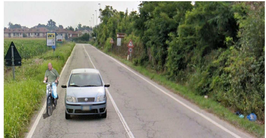
SEZIONE STRADALE LIMITATA A SOLI 7 METRI CON EVIDENTI RISCHI PER I CICLISTI
