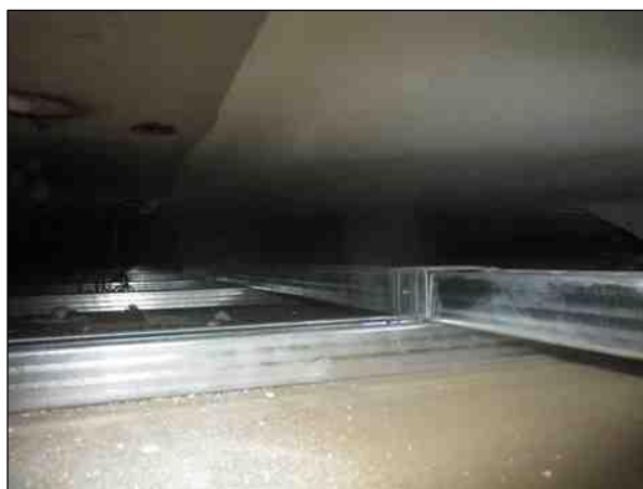
Foto n°1 - Atrio al piano terra, dettaglio del sistema di pendinaggio al solaio di supporto.
