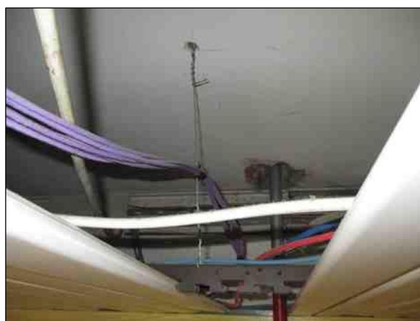
Foto n°2 - Sistema di pendinaggio del controsoffitto
