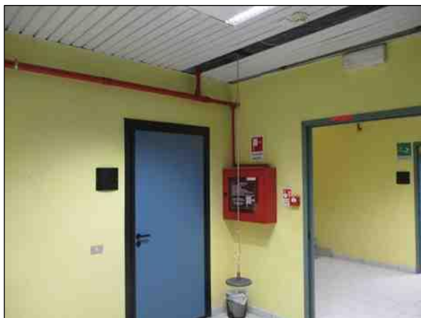
Foto n°5 - Vista della metodologia di prova per controsoffitto in doghe.
