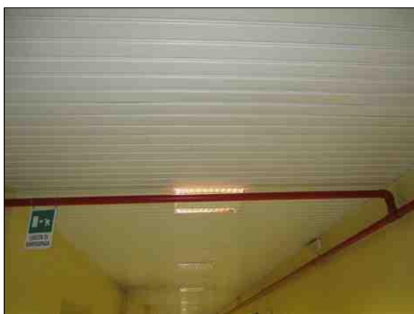
Foto n°1 - Vista della controsoffittatura in doghe nel Corridoio al piano seminterrato.
