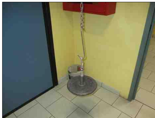
Foto n°6 - Vista dei pesi di prova per controsoffitto in doghe.
