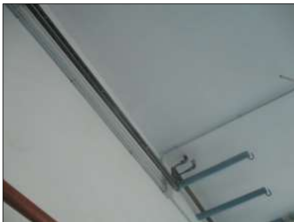
Foto n°25 - Porzione dell'intradosso del solaio della Palestra al piano terra connotata da una conservazione pessima.
