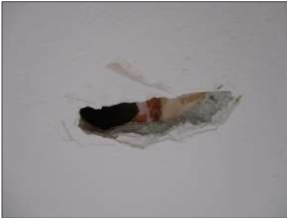
Foto n°13 - Visione d'insieme della micro-demolizione eseguita nell'Aula 1 al piano terra.
