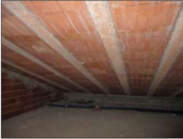
Foto n°16 - Individuazione della Tipologia Solaio 4 nel Sottotetto al piano secondo.
