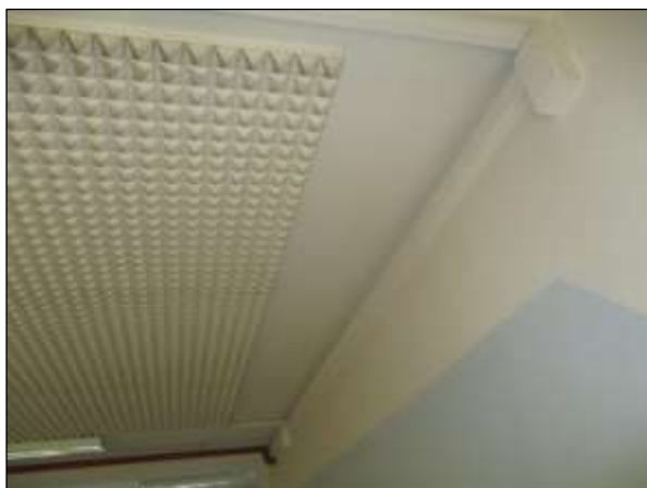
Foto n°27 - Porzione dell'intradosso del solaio del Refettorio 1 al piano terra connotata da una conservazione pessima.
