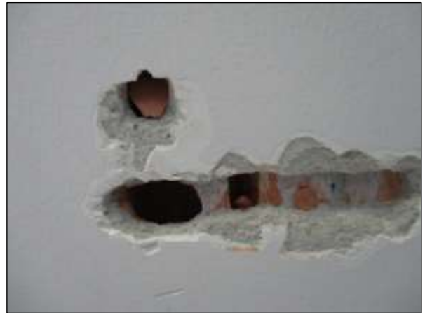
Foto n°12 - Particolare dello spessore della finitura presente all'intradosso del solaio.
