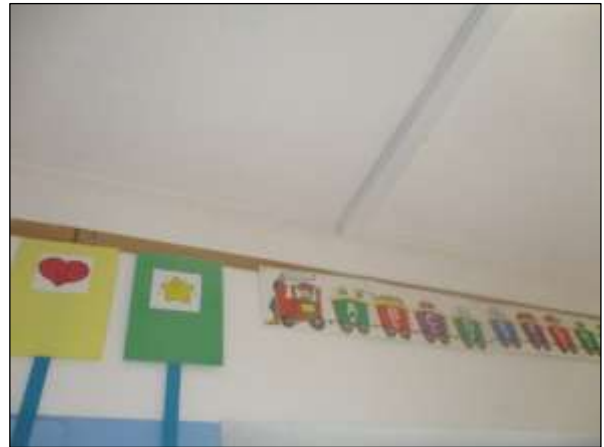
Foto n°20 - Porzione del plafone dell'Aula 1 al piano terra connotata da un grado di aderenza pessimo della finitura.
