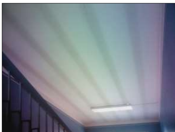
Foto n°9-10 - Individuazione della tramatura caratteristica dell'intradosso del Vano Scala 2 al piano secondo in cui è possibile riscontrare un'ulteriore tipologia costruttiva avente una scansione di travetti risultata costante ed uniforme sull'intera superficie dei plafoni, i cui contorni nitidi sono riferibili alla presenza di travetti prefabbricati.
