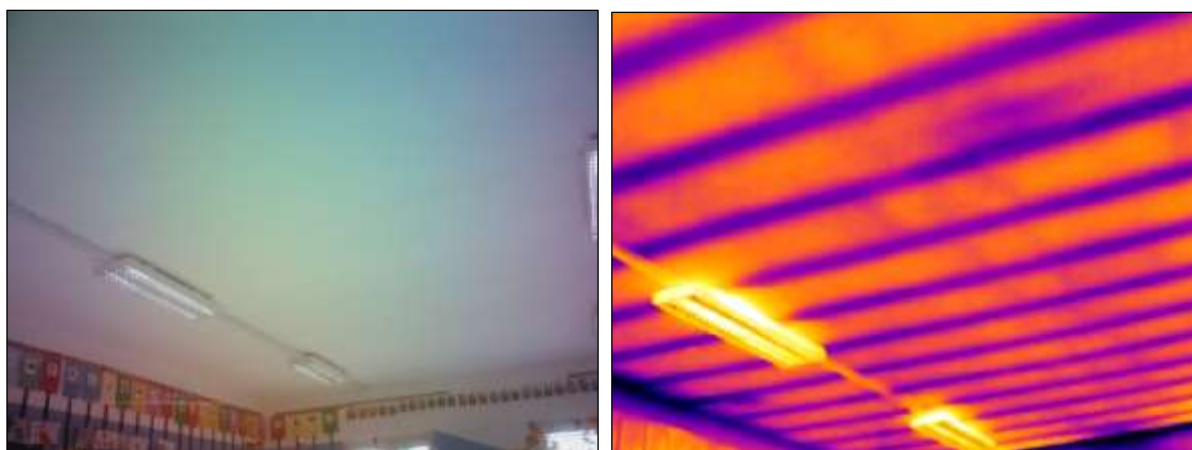
Foto n°3-4 - Il termogramma registrato nell'Aula 1 al piano terra dà la possibilità di riscontrare una seconda tipologia costruttiva.
