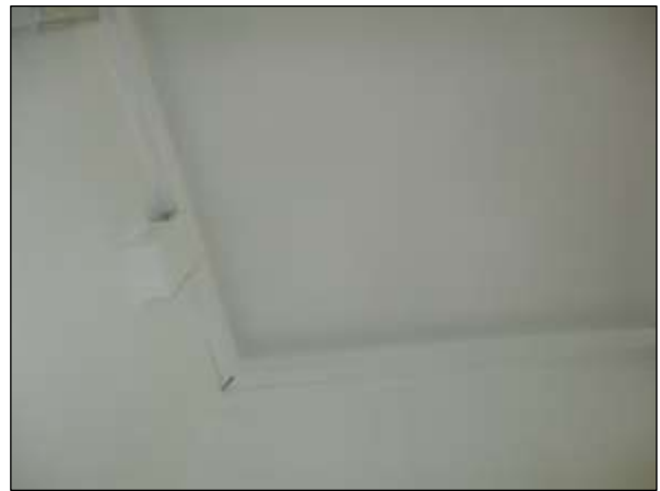
Foto n°22 - Porzione del plafone dell'Aula 2 al piano terra connotata da un grado di aderenza pessimo della finitura.
