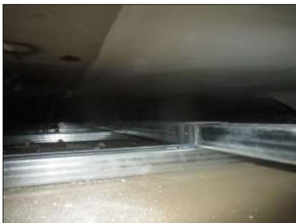
Foto n°18 - Intercapedine del controsoffitto in cartongesso riscontrato nell'Atrio al piano seminterrato.
