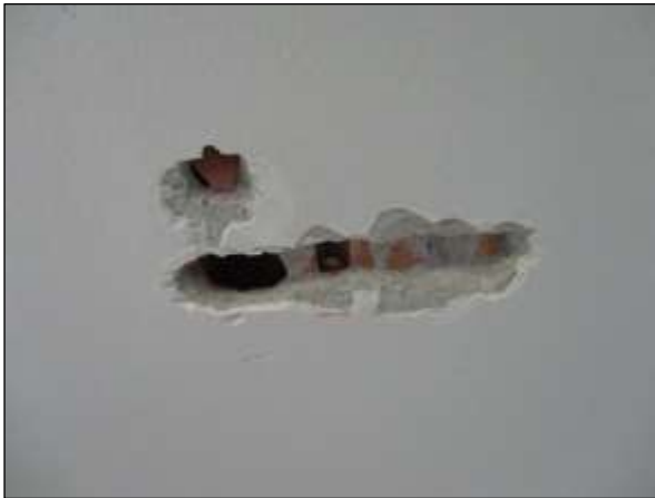
Foto n°11 - Individuazione della Tipologia Solaio 1; micro-demolizione eseguita nel Refettorio 3 al piano terra.
