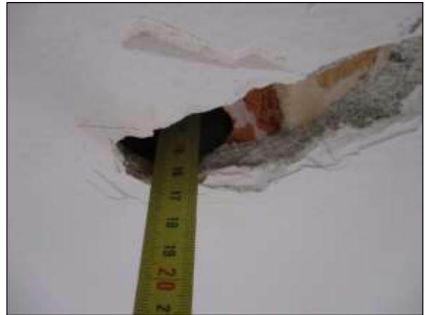
Foto n°14 - Dettaglio della misurazione dello spessore dello strato di finitura applicato al plafone.
