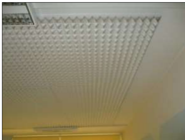
Foto n°17 - Pannelli fonoassorbenti riscontrati nel Refettorio 1 al piano seminterrato.
