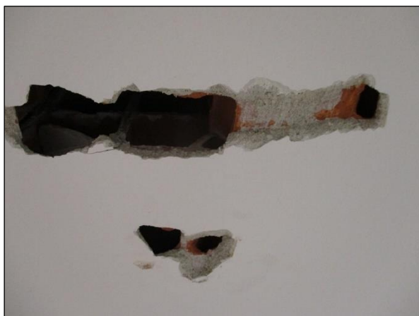
Foto n°11 - Individuazione della Tipologia Solaio 1; demolizione eseguita nell'Aula 6 al piano terra.
