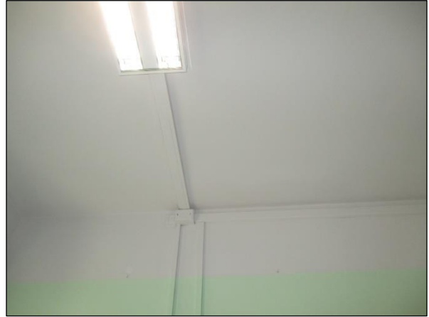
Foto n°29 - Porzione dell'intradosso dell'Aula 11 al piano terra connotata da una condizione pericolosa.
