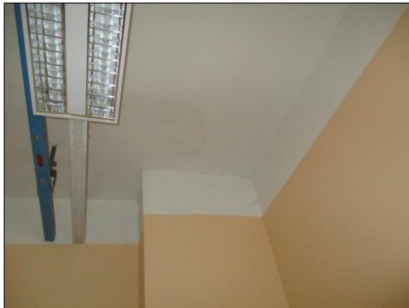
Foto n°21 - Porzione della finitura intonacata nell'Aula 3 al piano primo connotata da una condizione di conservazione pessima.
