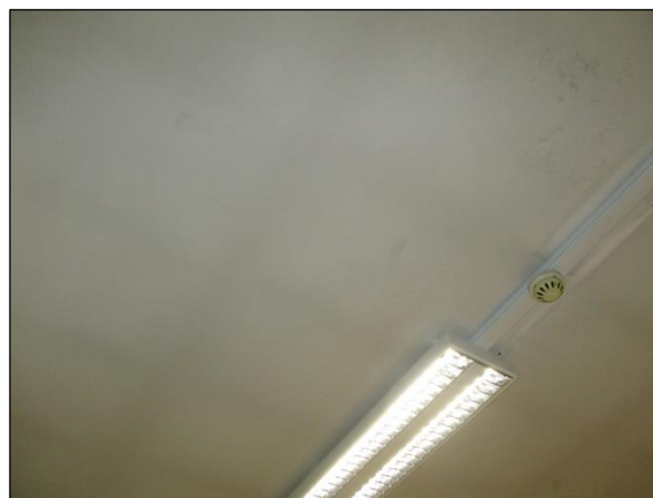
Foto n°20 - Porzione della finitura intonacata nel Laboratorio di informatica al piano seminterrato connotata da una condizione di conservazione pessima.
