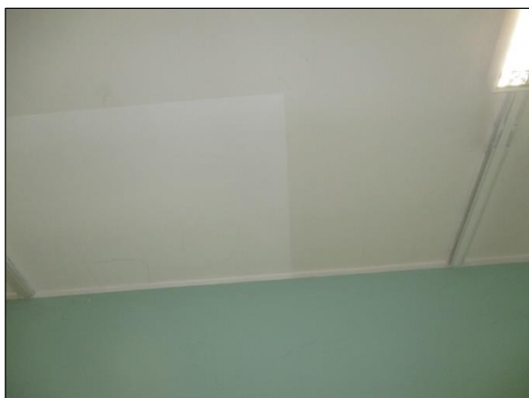
Foto n°24 - Porzione dell'intradosso dell'Aula musica al piano seminterrato connotata da una condizione pericolosa.
