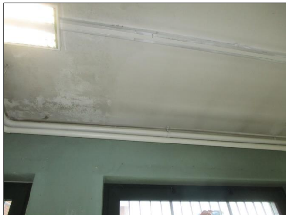
Foto n°23 - Porzione dell'intradosso dell'Aula musica al piano seminterrato connotata da una condizione pericolosa.
