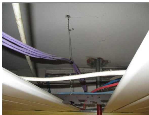
Foto n°17 - Sistema di pendinaggio del controsoffitto.
