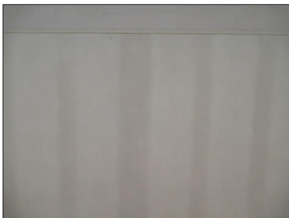
Foto n°26 - Porzione dell'intradosso della Palestra al piano terra connotata da una condizione pericolosa.
