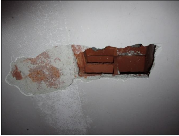
Foto n°13 - Individuazione della Tipologia Solaio 3; demolizione eseguita nel Deposito al piano primo.
