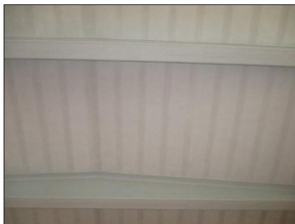
Foto n°27 - Porzione dell'intradosso della Palestra al piano terra connotata da una condizione pericolosa.
