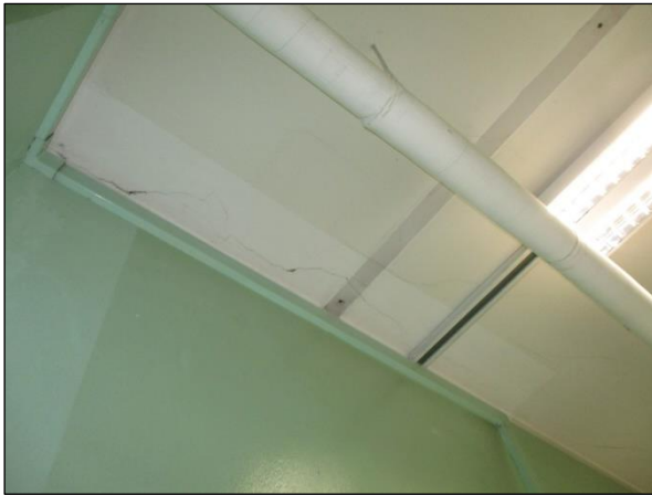
Foto n°30 - Porzione dell'intradosso del Laboratorio musica al piano seminterrato connotata da una condizione pessima.
