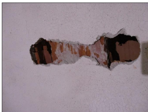
Foto n°12 - Individuazione della Tipologia Solaio 2; demolizione eseguita nell'Ingresso al piano terra.
