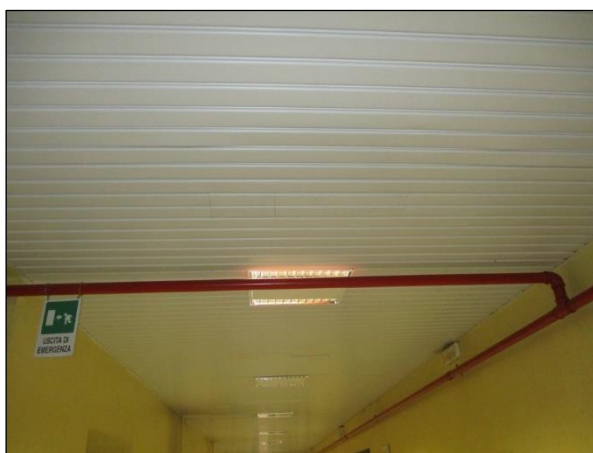
Foto n°16 - Vista della controsoffittatura in doghe nel Corridoio al piano seminterrato.
