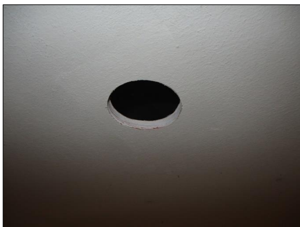
Foto n°14 - Vista del foro creato per ispezionare il controsoffitto in cartongesso nell'Aula 1 al piano terra
