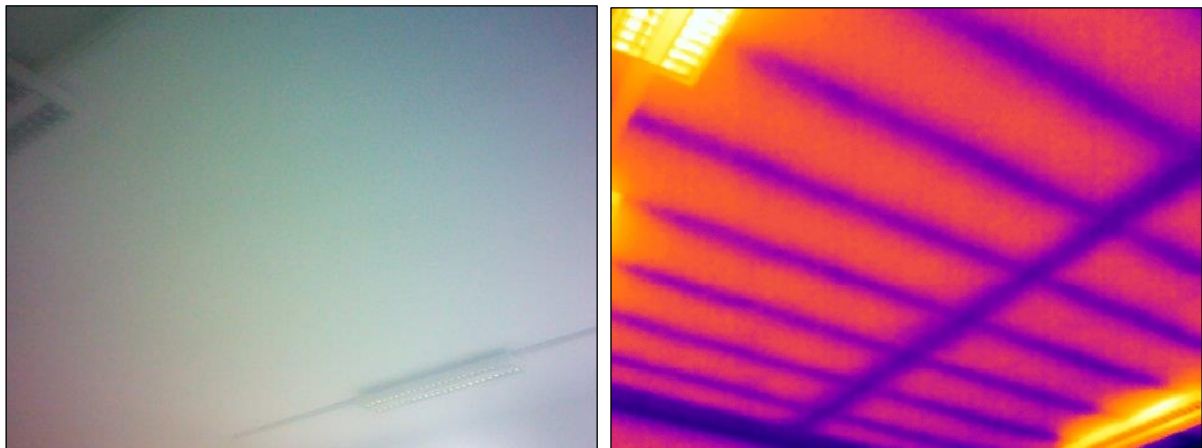
Foto n°1-2 - Individuazione della tramatura caratteristica dell'intradosso dell'Aula 5 al piano terra.
