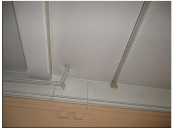
Foto n°31 - Porzione dell'intradosso della Palestra al piano seminterrato connotata da una condizione pessima.
