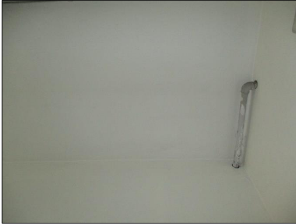
Foto n°28 - Porzione dell'intradosso del Bagno 1 al piano terra connotata da una condizione pericolosa.
