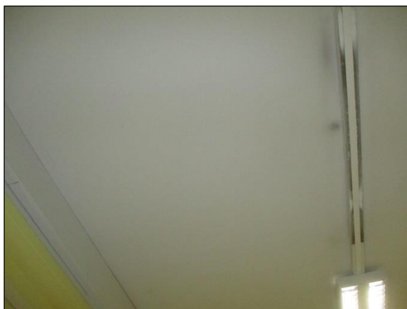
Foto n°19 - Porzione della finitura intonacata nel Corridoio al piano terra in procinto di distacco (condizione pericolosa).
