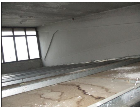
Foto n°15 - Vista dell'intercapedine del controsoffitto. Non è presente un sistema di pendinatura.
