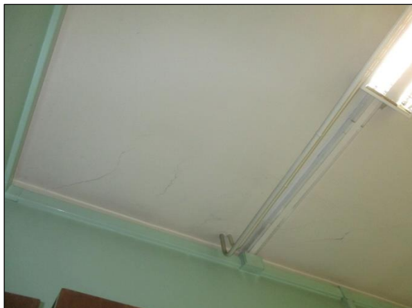
Foto n°22 - Porzione dell'intradosso dell'Aula musica al piano seminterrato connotata da una condizione pericolosa.
